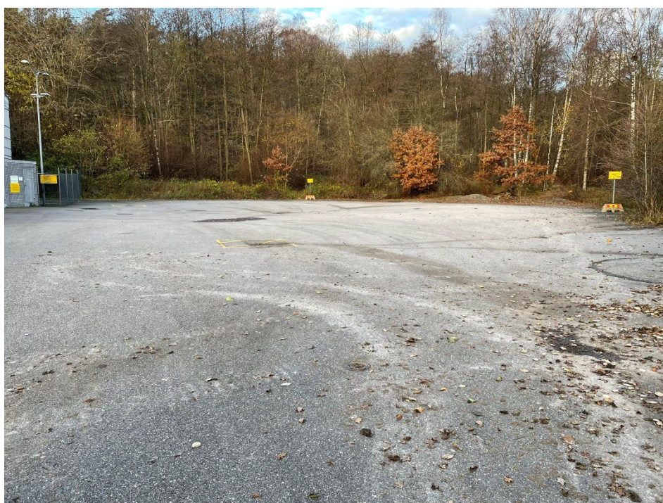
Figur 7. Befintlig lågpunkt inom planområde. Bild från platsbesök 2023-11-15
