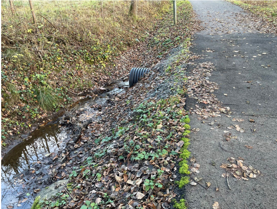
Figur 9. Trumma under befintlig cykelväg väster om planområdet. Bild från platsbesök 2023-11-15.
